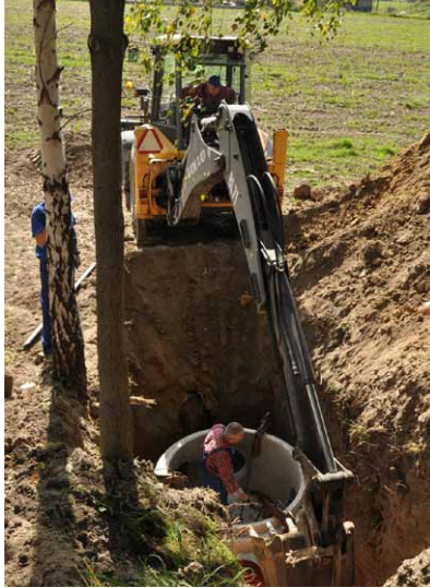
Budowa przepustu pod ul. Kóska
